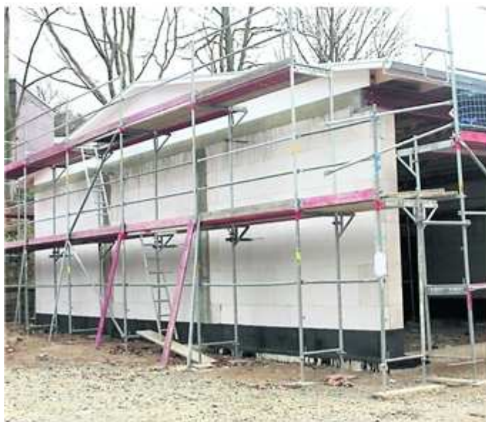
Richtfest über dem neuen DLRG-Heim im Bergbad: Bis Mai soll das Gebäude fertiggestellt sein.
